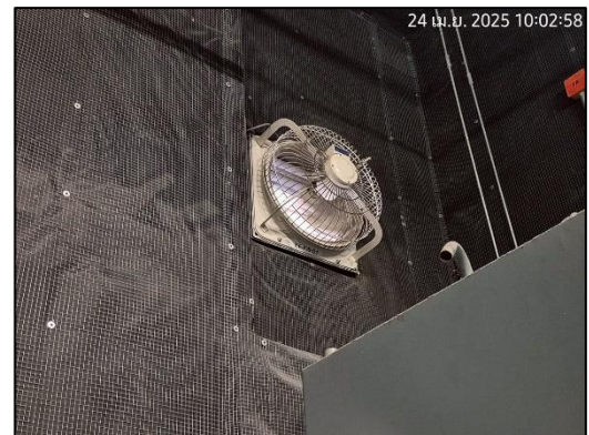
ภาพที่ 68 พัดลมระบายอากาศในห้องเครื่องกำเนิดไฟฟ้า
